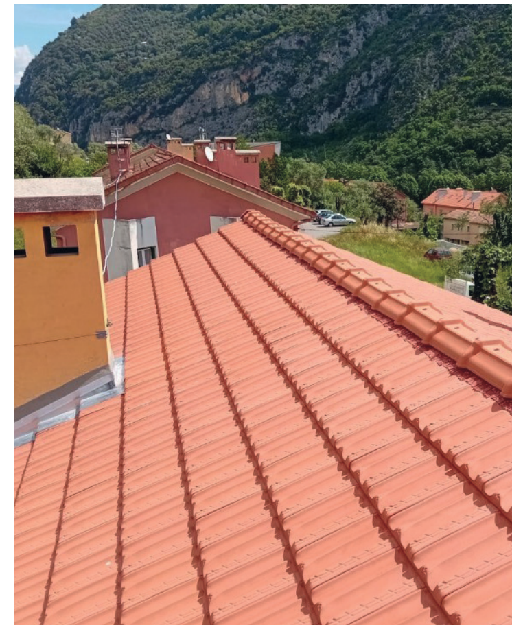
Réfection de la toiture et isolation des combles de la résidence Les Burdanches à Breil-sur-Roya
