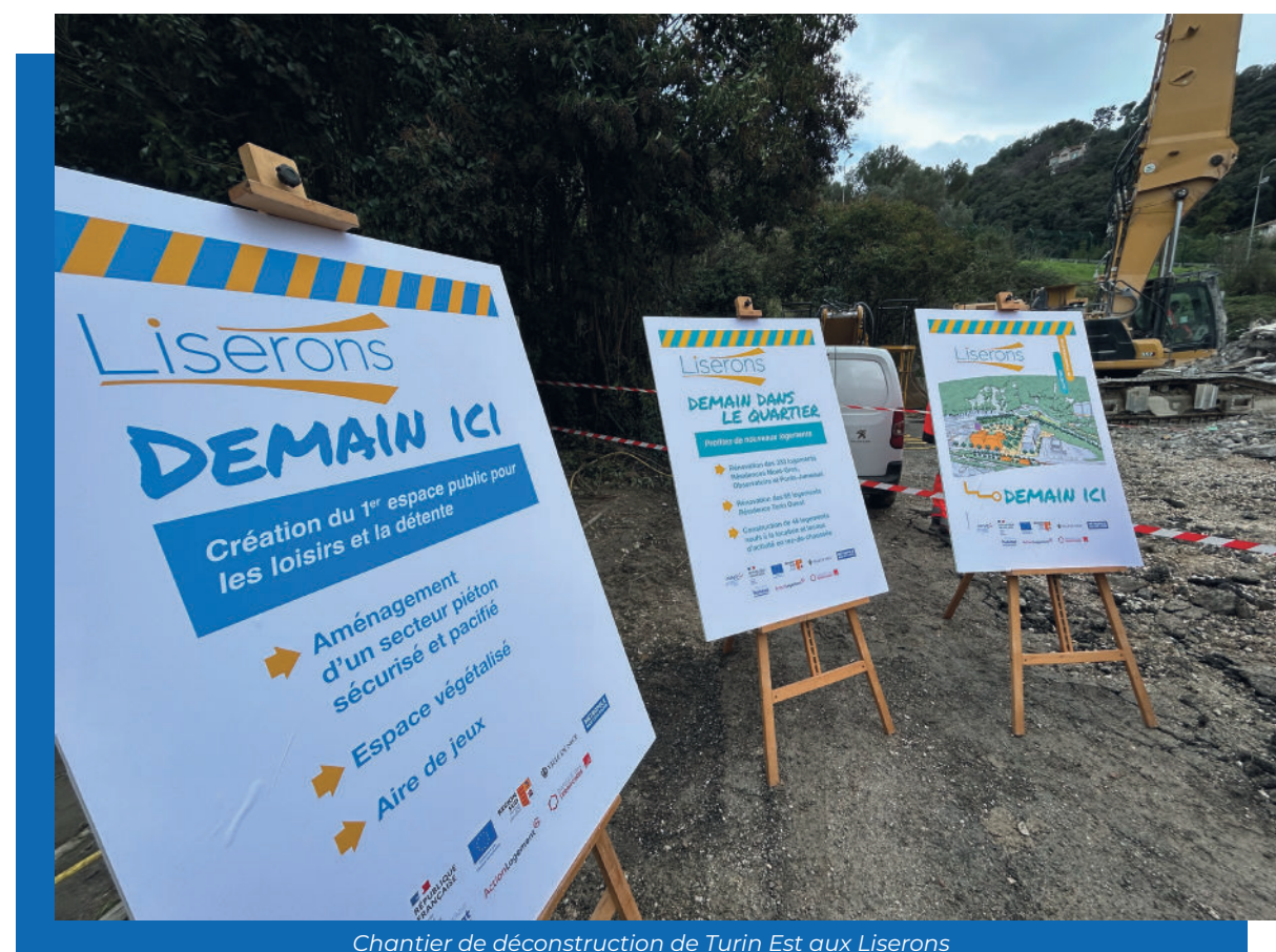
Chantier de déconstruction de Turin Est aux Liserons
