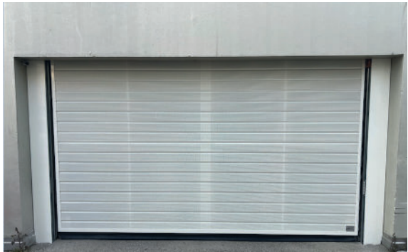
Porte de garage à la résidence Le Forum
