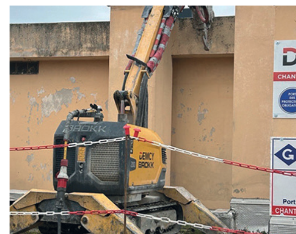
Déconstruction du bâtiment 17 aux Moulins
