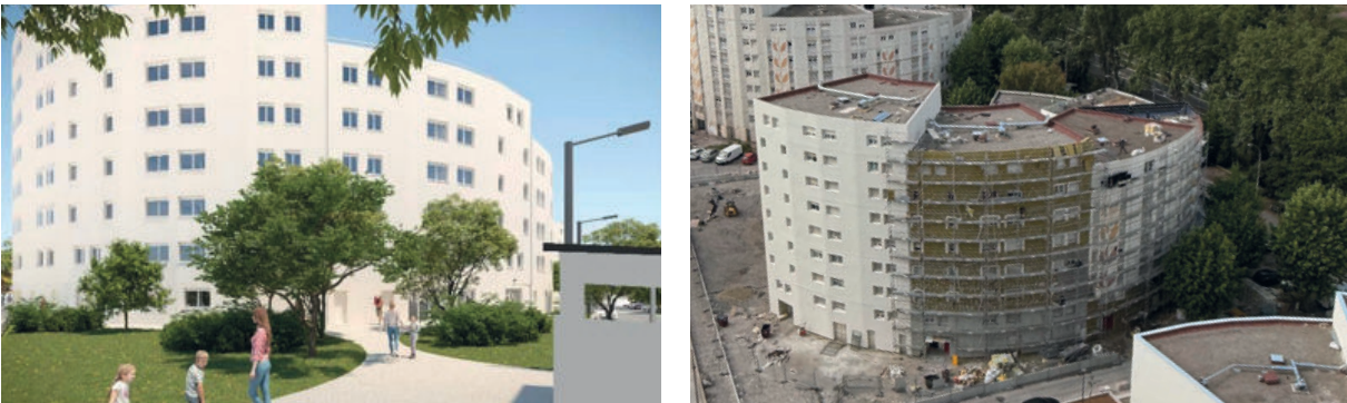
Réhabilitation des bâtiments 36 et 37 aux Moulins
